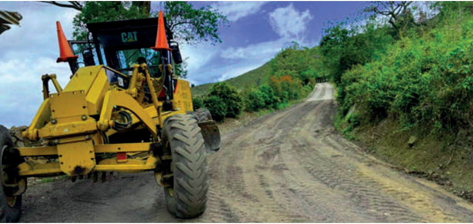
Maquinaria en operación realizando mantenimiento de vías con material entregado en calidad de donación.
