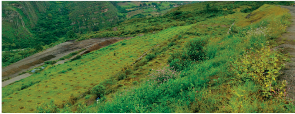
Revegetación ZODME No. 2 proyecto "Cantera el Pedregal".
