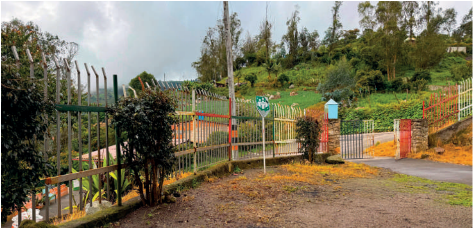
Obra de restauración del cerramiento ejecutada por Gravillera Albania S.A. Agosto 2025.
