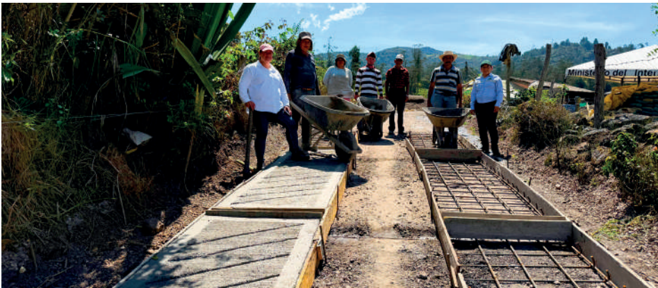
San Luis: Convenio Solidario 550-2024 Vereda San Luis Líder comunal: Presidente JAC Angela Milena Riveros Mora Obra: Placa Huella sector Vía San Luis – Salitre sector Los galpones Longitud 94 metros lineales Aporte de material en precio preferencial: $3.252.013
