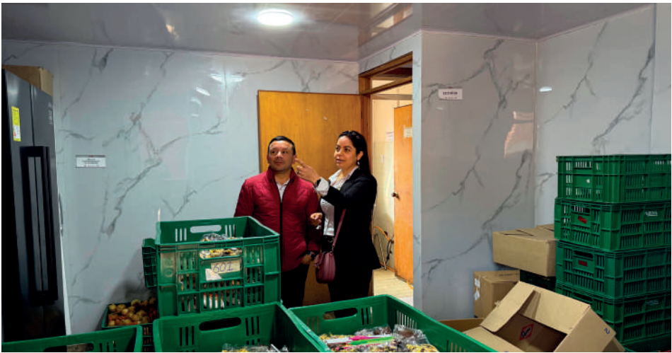
Bodega de almacenamiento de alimentos después de instalación de cielo raso en PVC.
