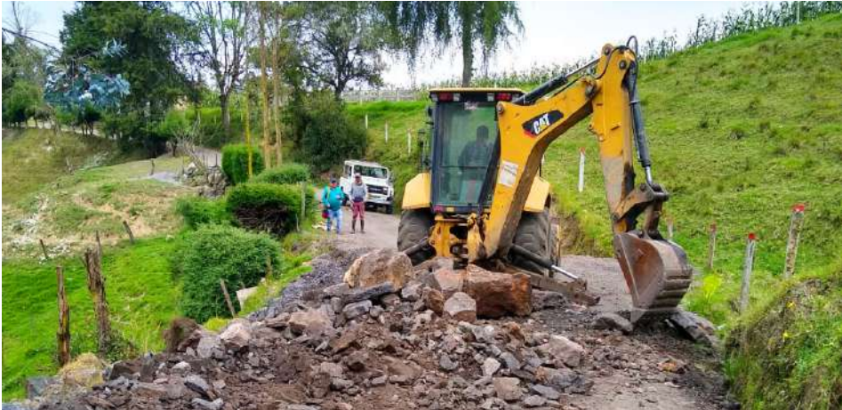
1 jul 2023. Obras de adecuación de vía en Vereda San Isidro, material crudo de mina y recho entregado en donación.
