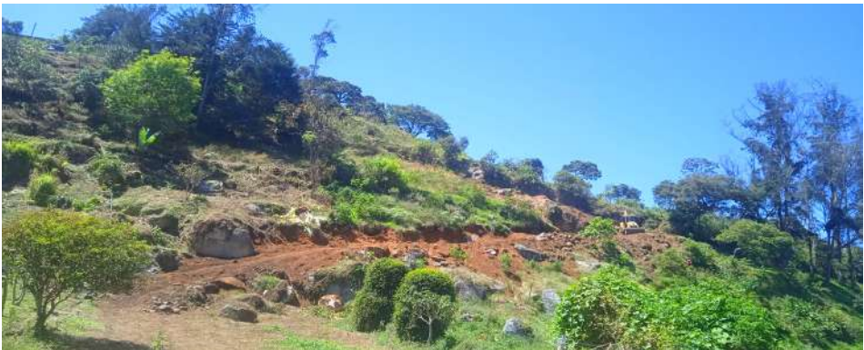
21 ene 23. Estado del camino cuando se iniciaron las obras de apertura de la vía antes de construir la placa huella en vereda Puente Tierra Sector Alto de las Ardillas.
