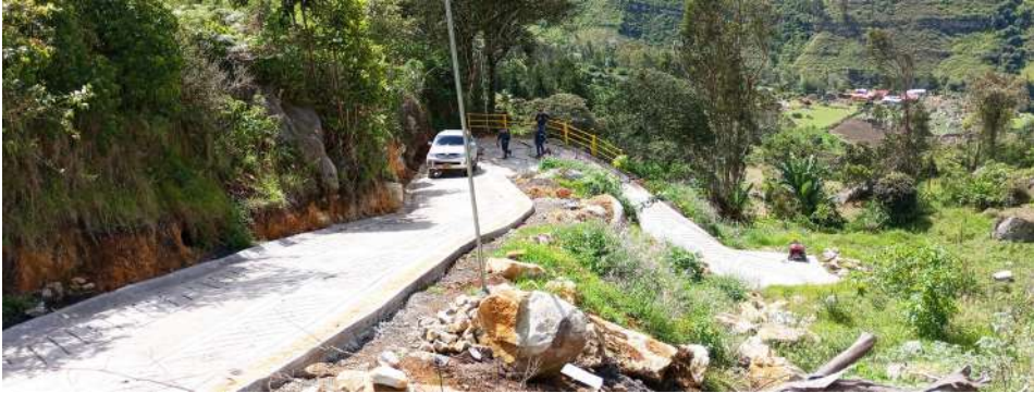
27 mayo 23. Se observa placa huella finalizada y en uso por los vecinos del sector Alto de las Ardillas Vereda Puente Tierra
