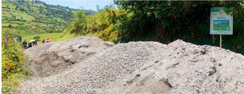
23 sep 23. Visita de campo en seguimiento al avance de obra sector Tres Esquinas Vereda Mategá. Se observa punto de inicio de obra, con el aviso de acceso a la vereda y el material agregado listo para la obra. Al fondo líderes y trabajadores de la comunidad ejecutando la obra.
