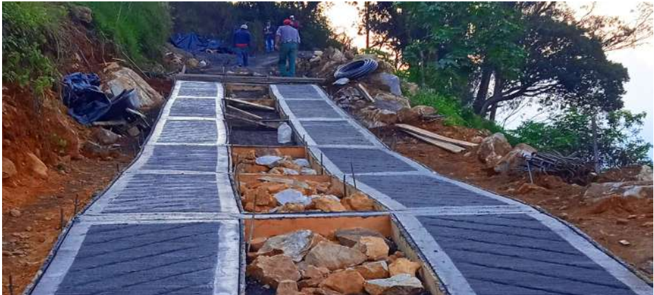
31 mar 23. Grupo de la comunidad realizando las actividades de construcción de la placa huella en Vereda Puente Tierra Sector Alto de Las Ardillas.
