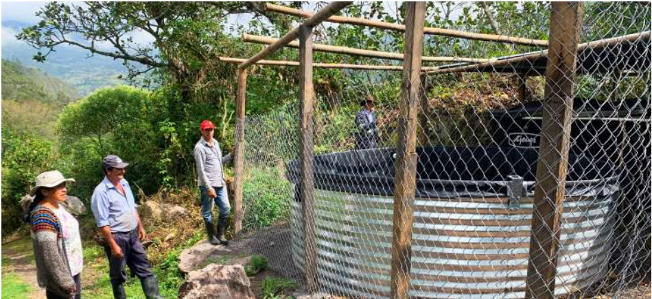
30 ago. 23. Visita de seguimiento con comunidad y líderes de JAC Hoya de Carrillos a la obra de adecuación y cerramiento del lote de estructuras de acopio de agua potable de la vereda.
