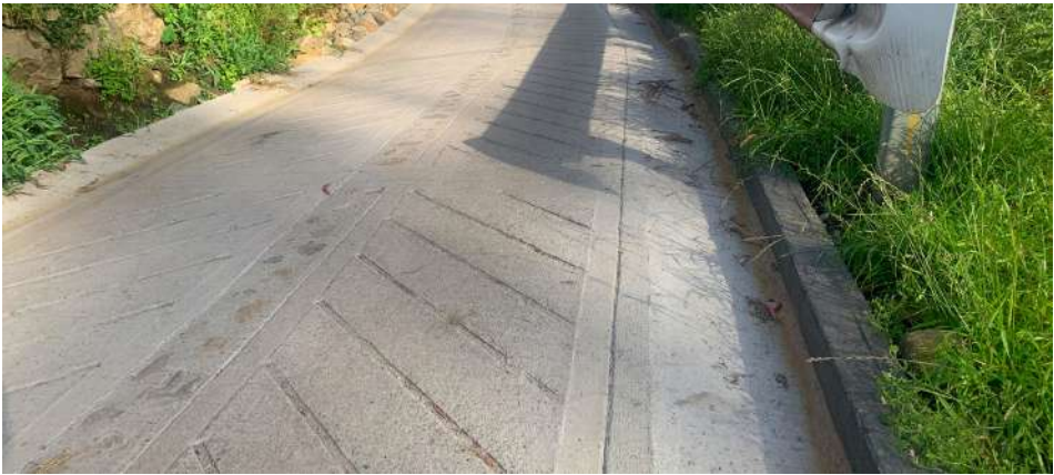
23 ago. 23. Alameda construida en la vía que comunica la vía al Salitre con la Urbanización Villa Natalia en Une.
