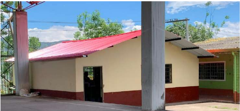
21 sep 23. Se observa obra finalizada en el Salón comunal Puente Tierra, evidencia del cambio de cubierta o tejado.
