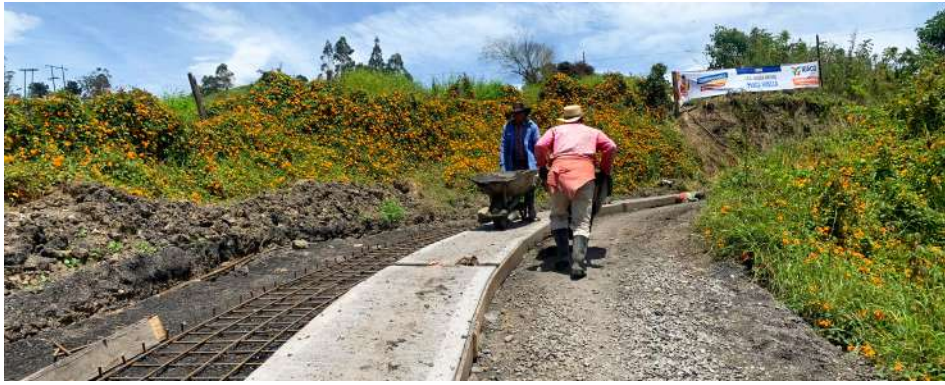
Placa huella terminada y en uso por la comunidad, obra del sector Piedra grande vereda Mategá
