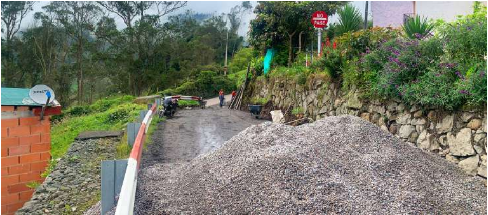
26 jun 23. Inicio de obra para construcción de la alameda de acceso a la vía Villa Natalia - Salitre, se observa llegada de material agregado para la obra.
