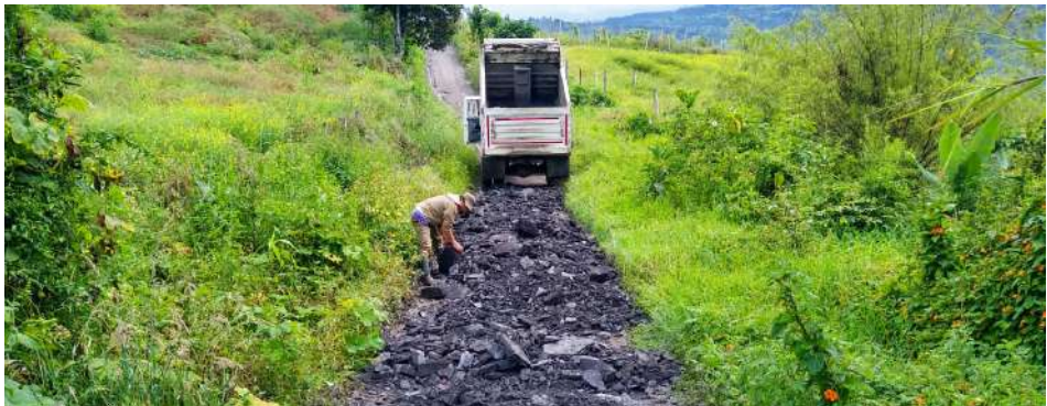
17 ago. 23. Volqueta de propiedad del municipio de Une realizando la adecuación de vía rural en Vereda Mategá vía La Quinta a Une.
