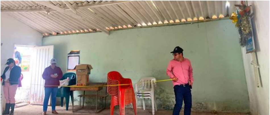
1 mar 2023. Visita de evaluación de la condición del salón comunal, en la foto profesionales de la Secretaría de Infraestructura y Planeación de Une, tomando medidas del lugar.
