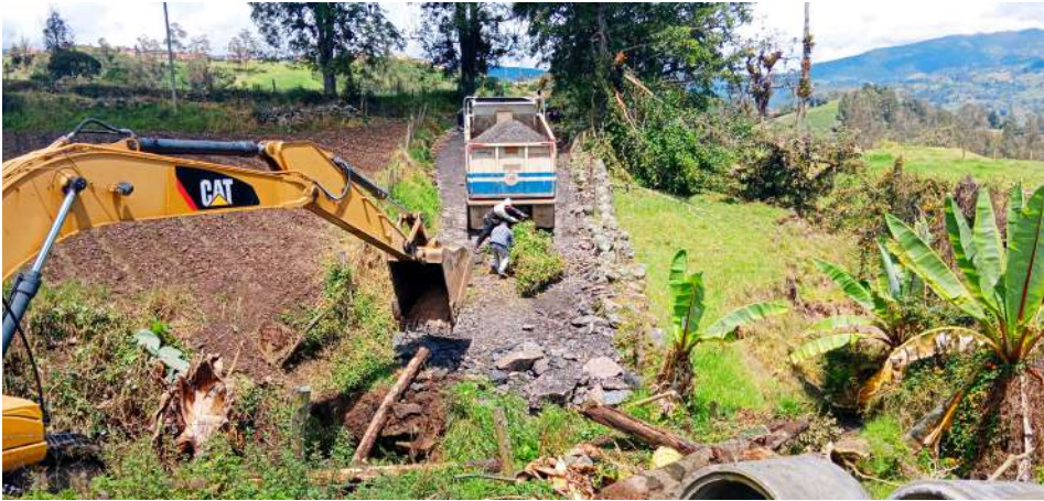
12 sep 2023. Volqueta del municipio de Une realizando descarga del material y excavadora del municipio haciendo la disposición para adecuación de paso alternativo en Vereda San Luis, obra para la cual se entregó recho y crudo de mina en calidad de donación.
