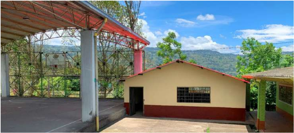
21 sep 23. Se observa condición del Salón comunal Puente Tierra después de las labores de pintura general.
