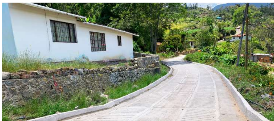
Obra terminada placa huella sector Aguas Calientes vereda Timasita.
