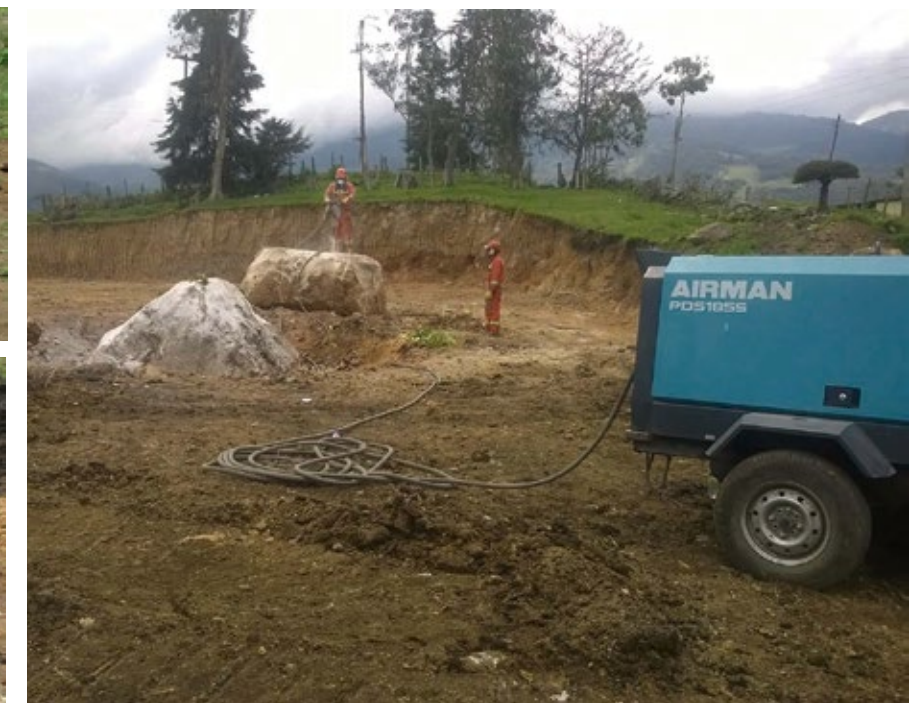
Apoyo Obra Polideportivo Vereda Combura
