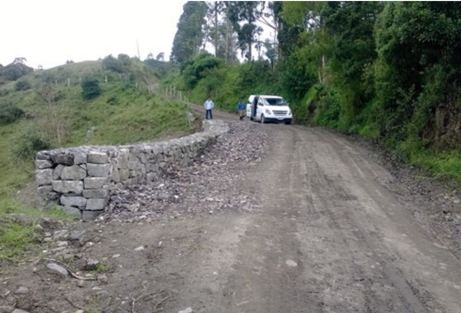
Obra vía terciaria Vereda Mategá
