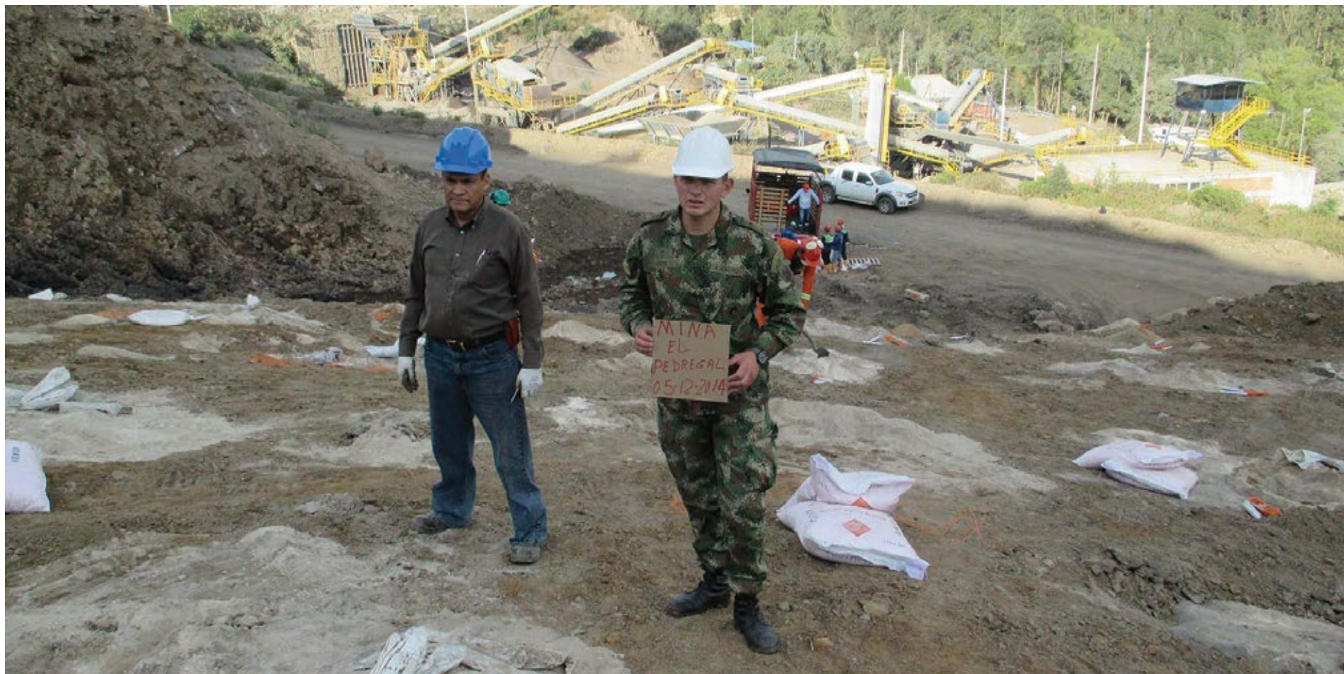
El Ejército Nacional hace presencia con el material y se da por instalado el evento de voladura para la fecha.
