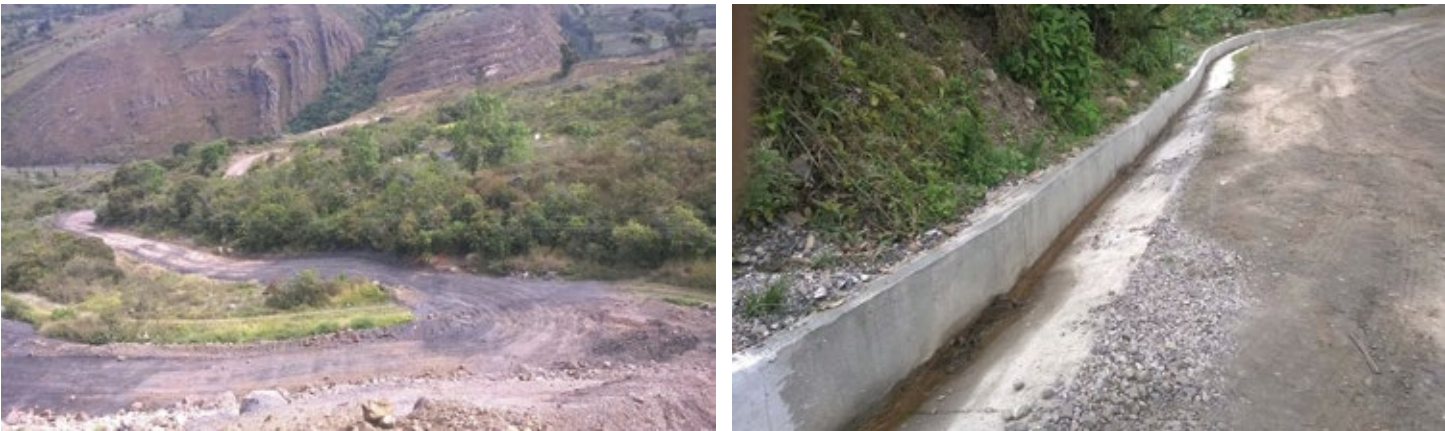
Obras de adecuación de la vía de servidumbre sector Hoya de Carrillos
