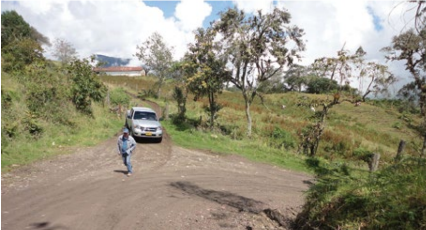
Obras de mejoramiento de vías terciarias Municipio Une
