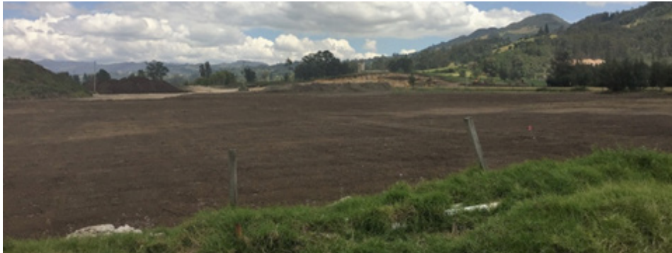
Capa vegetal instalada módulo VI-A oriental
