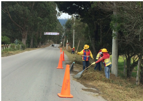
Mantenimiento vía Variante-Planta Gravillera Albania
