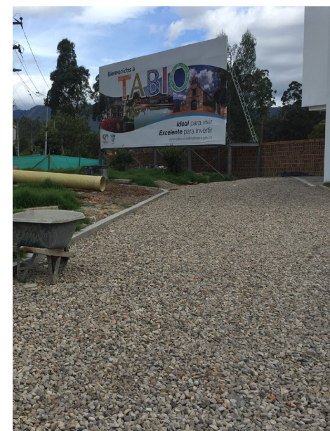
Obras de senderos en la Estación de Policía
