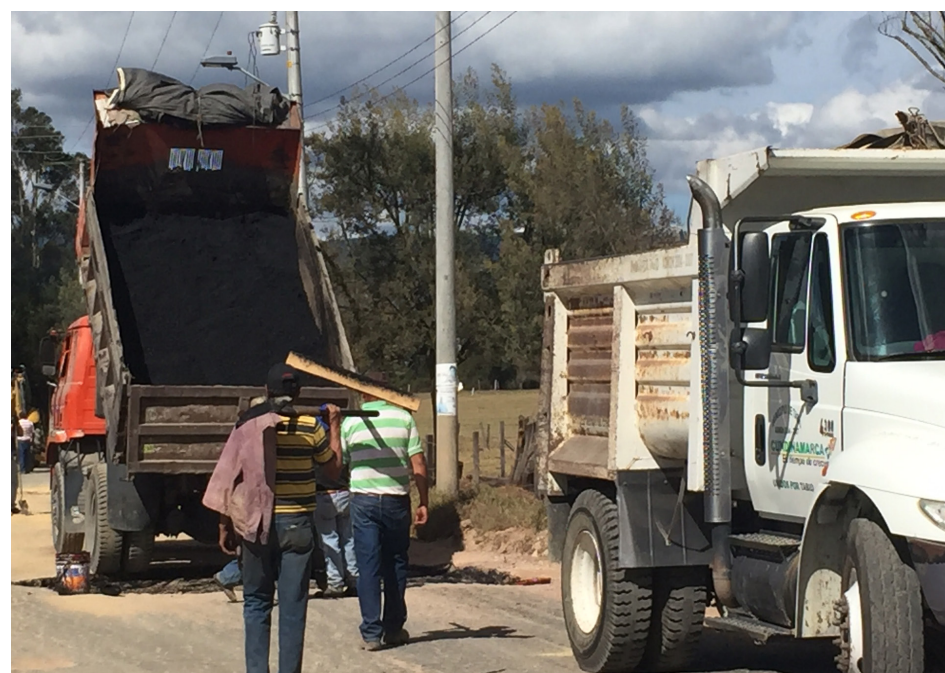
Entrega de asfalto para adecuación de la vía variante Riofrío Oriental.
