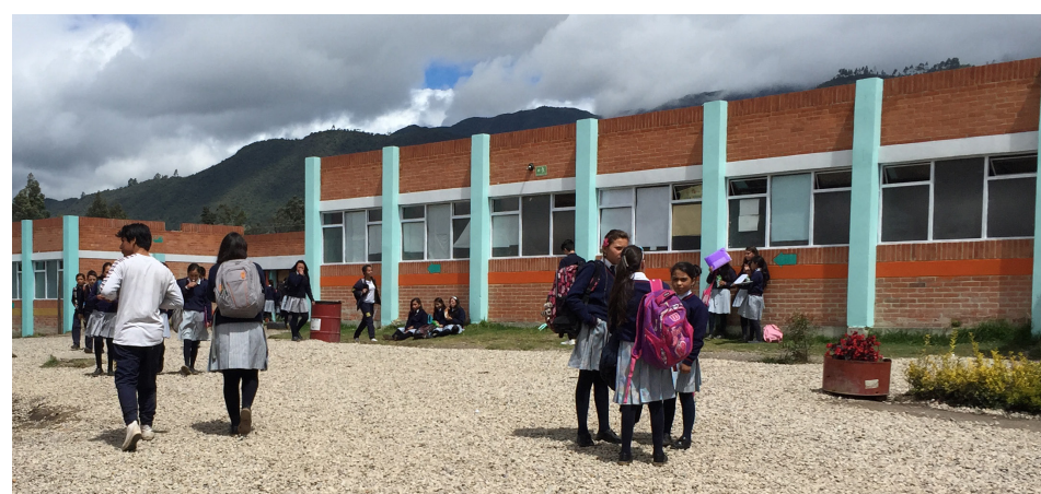
Obra IERD DIEGO GOMEZ para mejoramiento de zonas peatonales centrales 30 oct 2015
